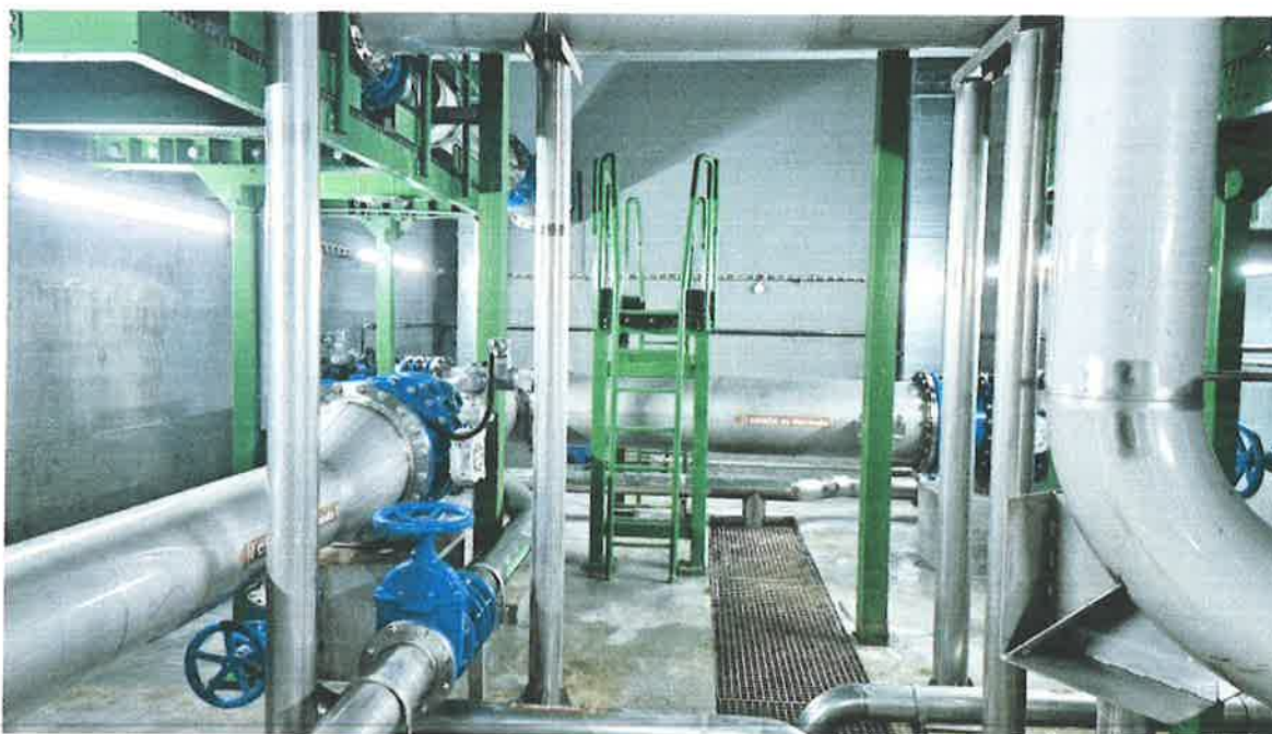
Vodojem Vysoká Srbská 3000 m 3 (foto Štěpán Bartoš)
