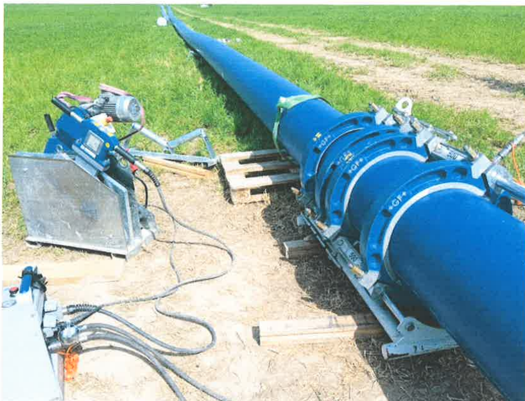
Rekonstrukce vodovodního přivaděče VSVČ
