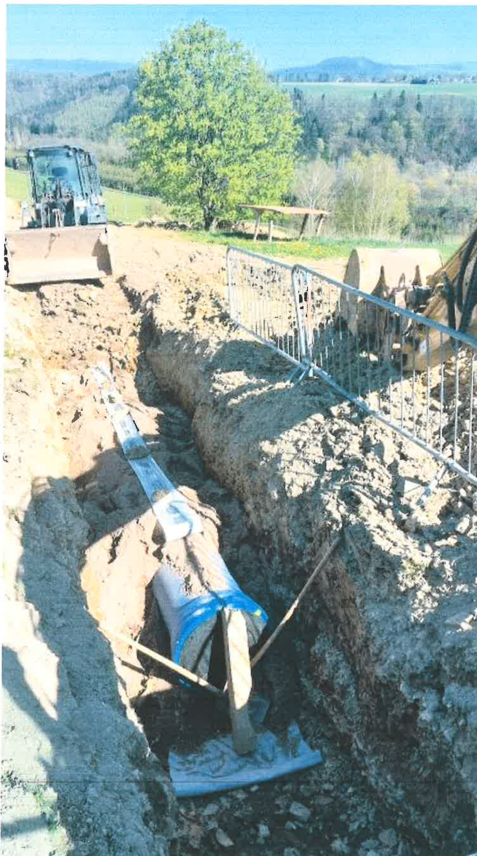
Rekonstrukce vodovodního přivaděče VSVČ
