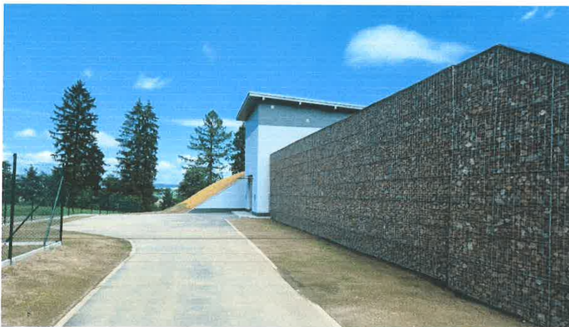
Vodojem Vysoká Srbská 3000 m 3 (foto Štěpán Bartoš)
